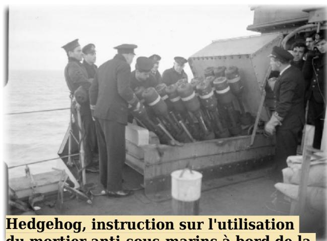
**Hedgehog, instruction sur l'utilisation du mortier anti-sous-marins à bord de la corvette RN Tompazis.**
