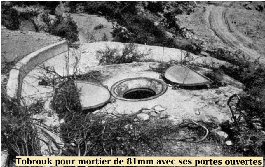
**Tobrouk pour mortier de 81mm avec ses portes ouvertes**
