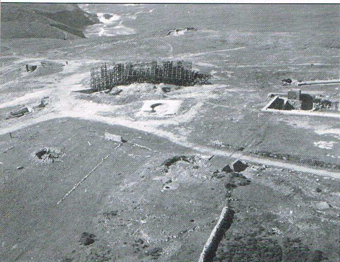
Le Mammut sur la colline de Lescoff entouré de cuves de Flak plutôt sommaires, d'un abri-projeteur, de deux L622 et d'un R667. Dans l'excavation d'une carrière se trouve la cantine. La grande antenne est en cours de ferrailage. (SHM 1946.)
