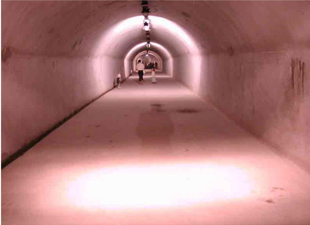
De chaque côté des murs, se trouve une rigole pour recueillir l'eau des infiltrations.
