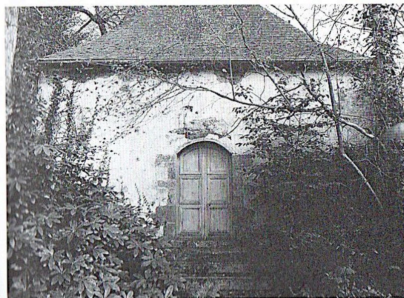
Porte de la chapelle de la Morinais (propriété appartenant à M. Fleuriot de Langle).
